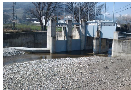
Ilustración 10. Presa de desvío o aliviadero
