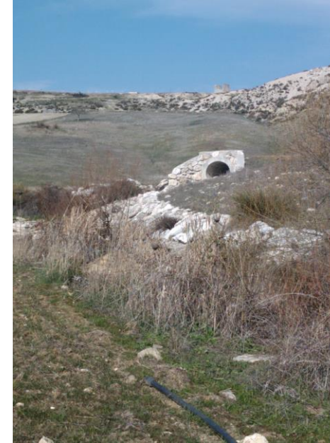
Ilustración 12. Salida del túnel de trasvase en al cuenca del Aº de Puente Piedra (diám. 3,5 metros)
