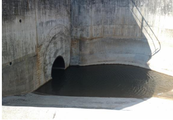
Ilustración 11. Entrada al túnel (reducida recientemente)
